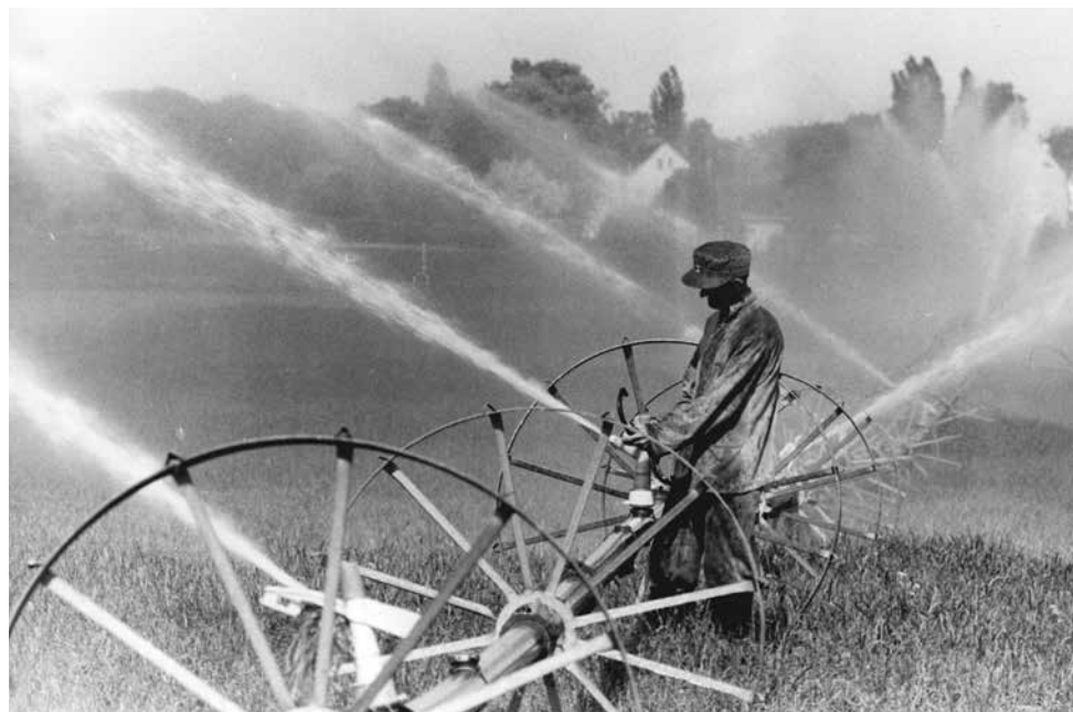
Bewässerungsanlage der Kooperativen Abteilung Pflanzenproduktion in Lichtenberg-Weißensee, Juli 1973. Pro Stunde wurden etwa 2.000 Kubikmeter Wasser auf die Felder gepumpt.
