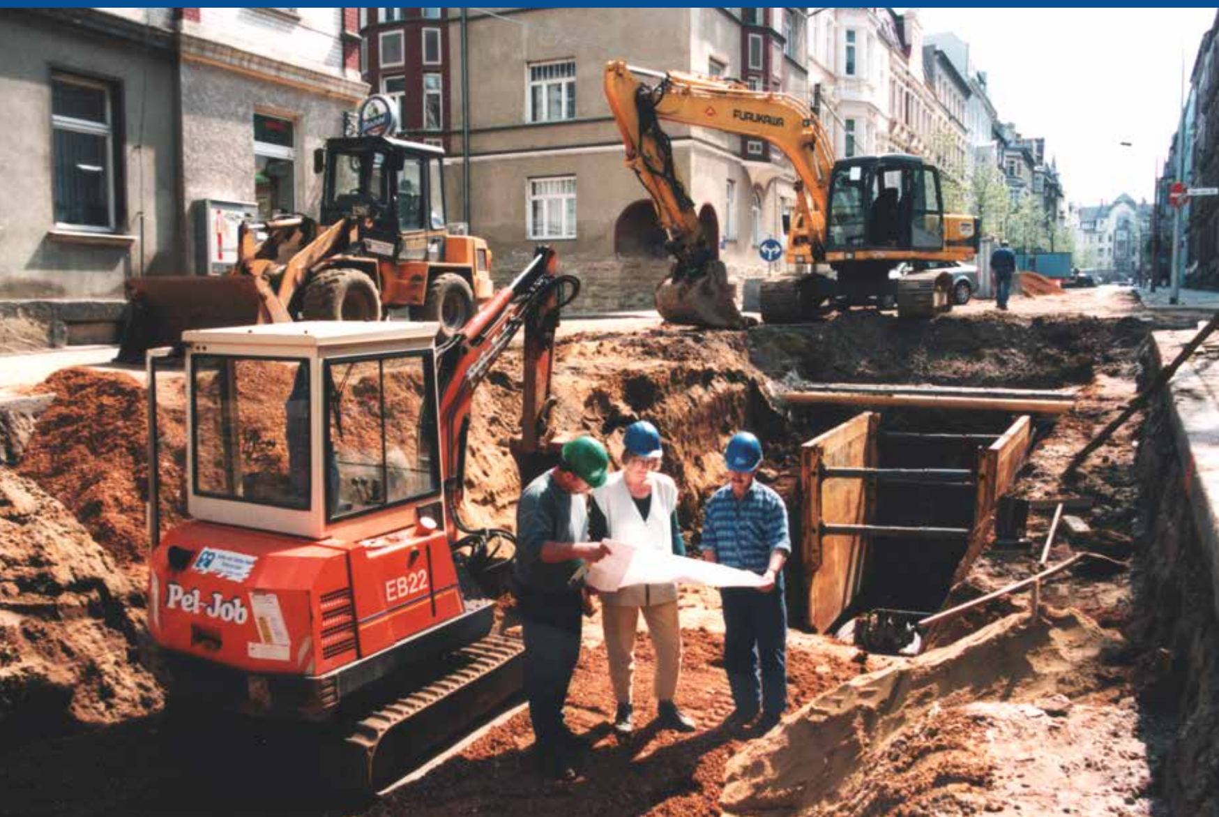
Unten: Ausbau- und Modernisierungsmaßnahmen am Zeitzer Kanalnetz in der Von-Harnack-Straße, April 1998
