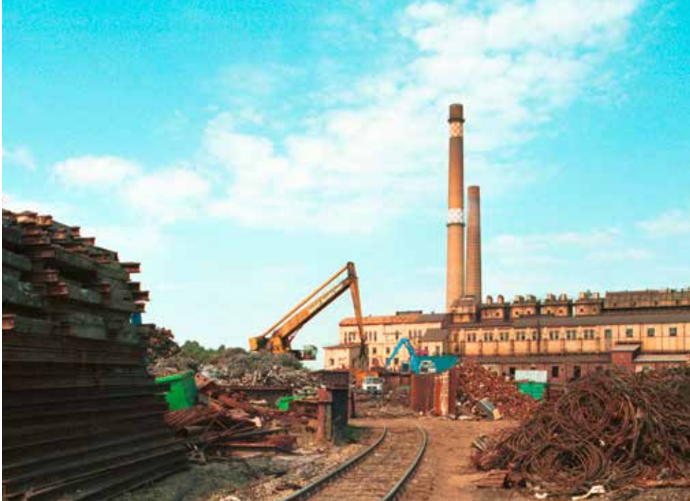
In Lauchhammer (Brandenburg) wird eine Fabrik abgebaut, Juli 1994
