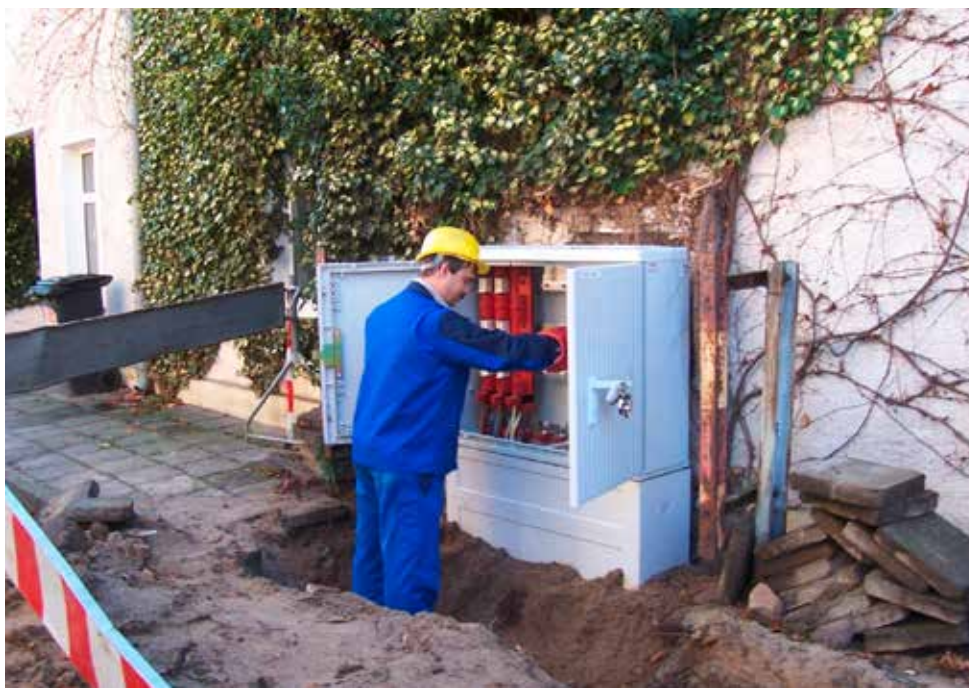
Mitarbeiter von PVU an einem neuen Stromverteilerkasten, ca. 1997
