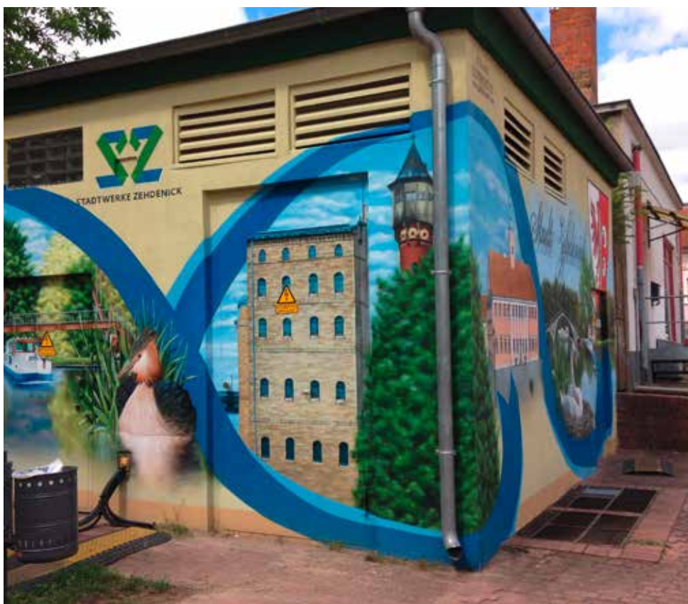
Umspannstation der Stadtwerke im Stadtbild Zehdenick, 2016
