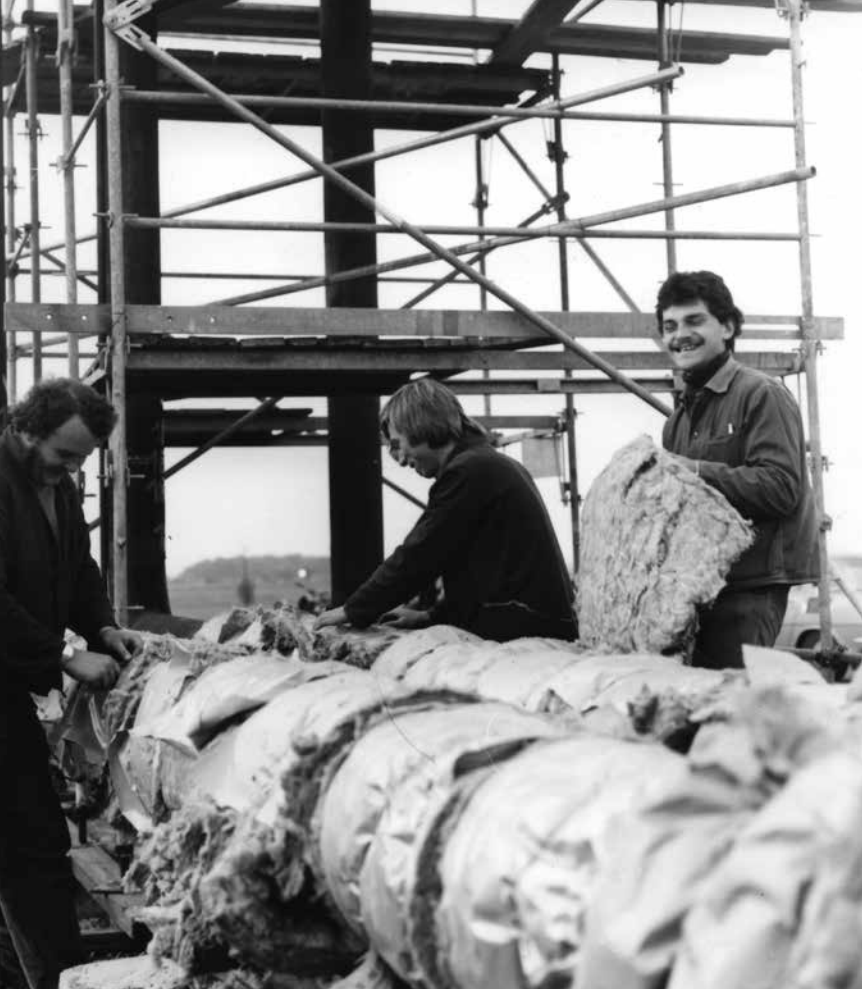
Oben links: Gedämmte oberirdische Leitungen wie diese brachten in der DDR die Fernwärme vom Kraftwerk Deuben nach Zeitz, ca. 1980er-Jahre
