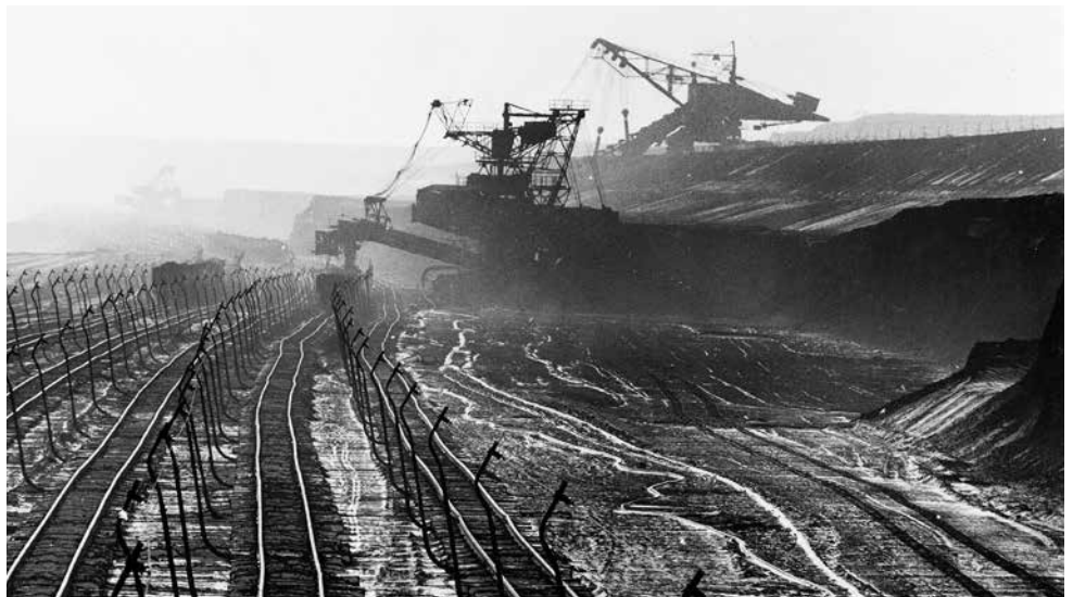
Braunkohlentagebau „Einheit“ in Bitterfeld, 1968. Blick auf die Gleisanlagen der Grubenbahn, Kohlenbagger und Abraumbagger (an der Tagebaukante)
