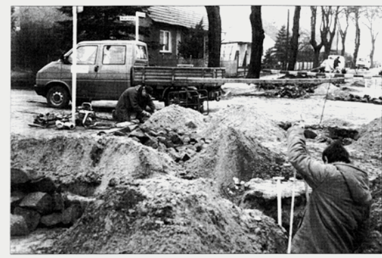
Die Arbeiten der Preussag Anlagenbau GmbH beim Verlegen von Gasrohren im Bereich Mozart-, Schiller- und Märkische Straße sollen noch in diesem Monat abgeschlossen werden. Begonnen wird im Annerwalder Weg. Foto: H.-J. Eggert
