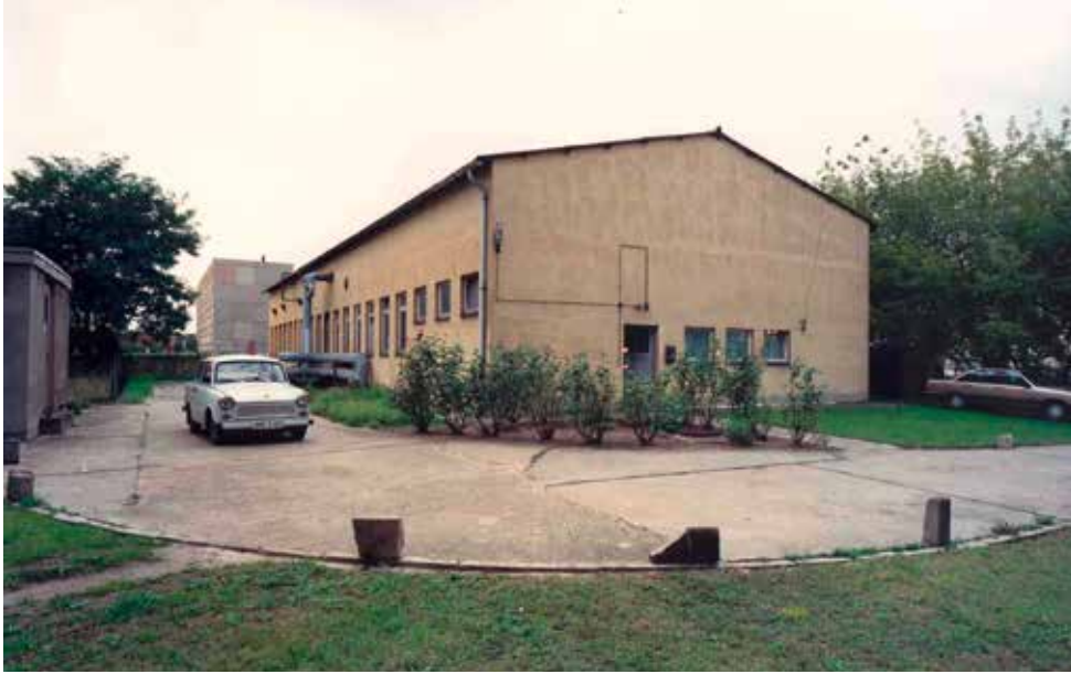
Die alte Fernwärme-Umformerstation von PVU in Wittenberge, 1991
