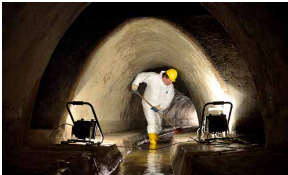
Reinigungsarbeiten in einem begehbaren Kanal in der Dresdener Kanalisation, 2013
