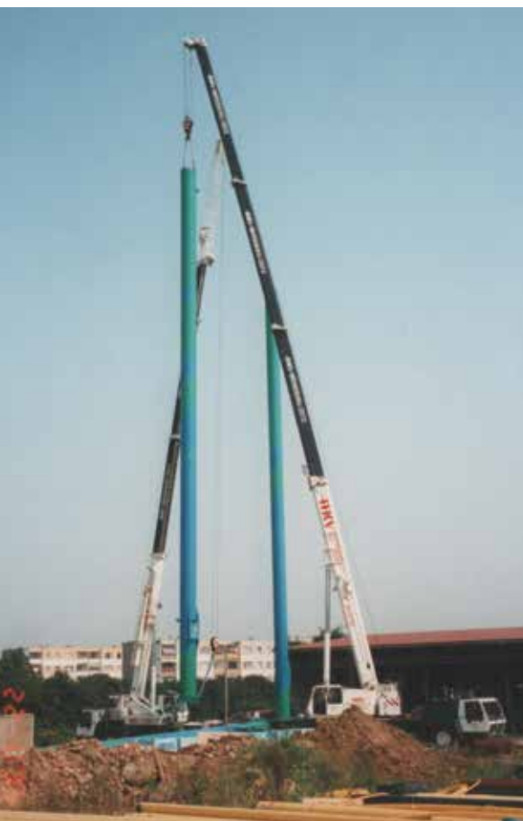
Neue blau-grüne Schornsteine für die neuen Heizkessel und BHKW-Module in Zeitz, dahinter das Heizhaus, 1995
