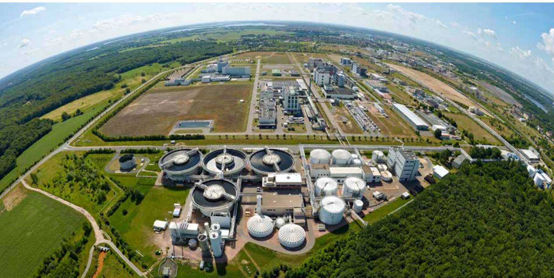
Luftbild des Chemieparks Bitterfeld-Wolfen; vorne: Gemeinschaftsklärwerk des Chemieparks, 2012
