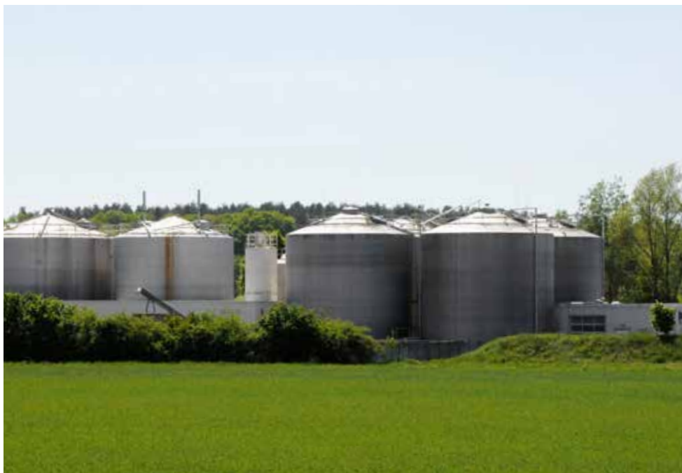
Kläranlage der Entsorgungsgesellschaft mbH Neues Land, Calvörde, 2018
