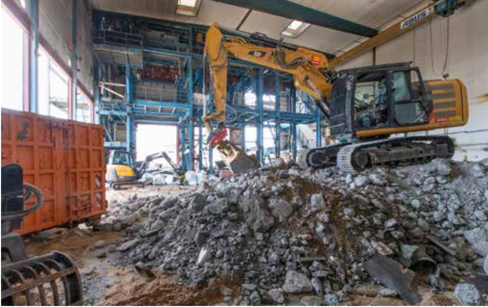
Oben und links unten: Kraftwerkssanierung zur Sicherung der Fernwärmeversorgung in Stendal, 2018
