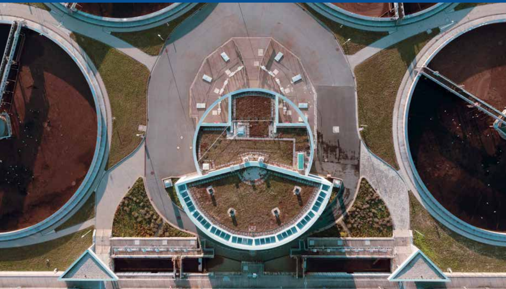
Unten: Luftaufnahme des Maschinenhauses der Kläranlage Dresden-Kaditz, 2019
