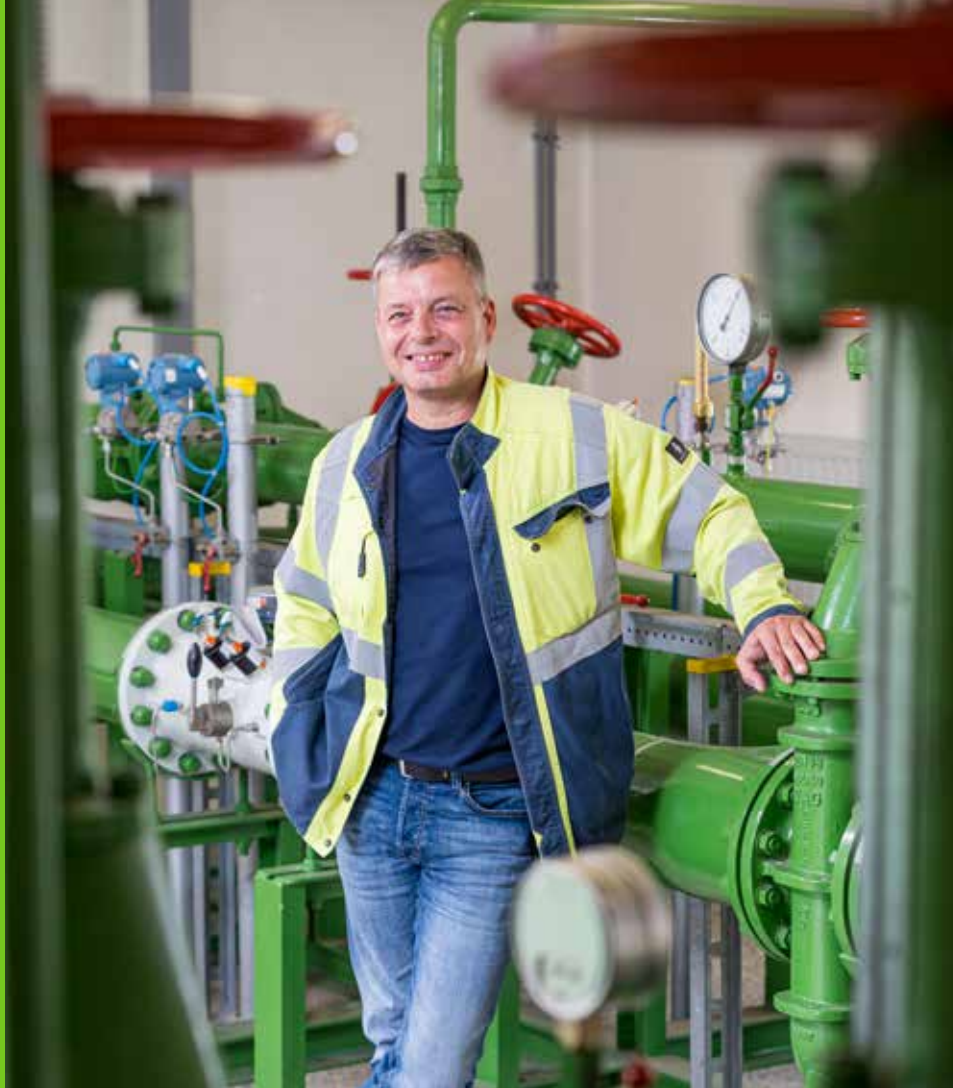
◁ Thomas Hillebrand vor einer Gasdruckregelanlage der Stadtwerke Burg, Juni 2020
