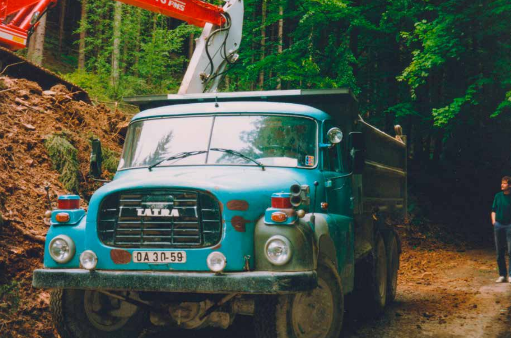
Oben: Vorbereitungen für den Bau eines neuen Wasserbehälters für die Ortschaft Neu-Leibis, 1992/1993
