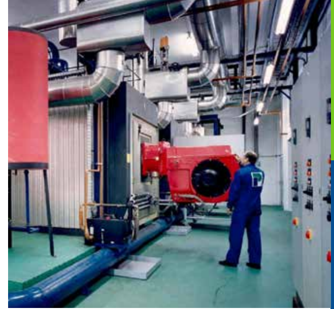
Heizhaus 3 in Wittenberge nach der Modernisierung, ca. 1992
