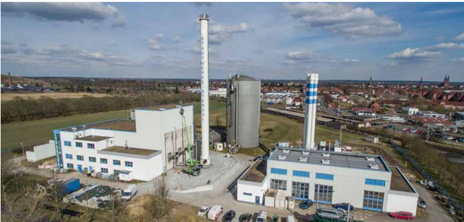
Die Heizkraftwerke (hier in der Schillerstraße, 2018) dienen der ökonomischen Erzeugung von Fernwärme durch Kraft-Wärme-Kopplung. Aufgrund der optimalen Ausnutzung der eingesetzten Brennstoffe in den Heizkraftwerken wird der Ausstoß von Treibhausgasen vermieden. Durch modernste Filteranlagen werden Schadstoff- und Feinstaubbelastungen in Stendal erheblich vermindert, was zur Umsetzung des Klimaschutzkonzepts Stendals beiträgt.
